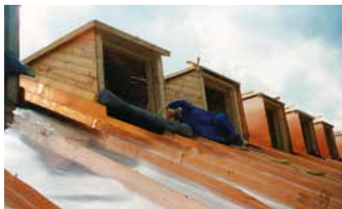
Dachgeschossausbau 1994 (Foto: Minna Ronnefeld)
